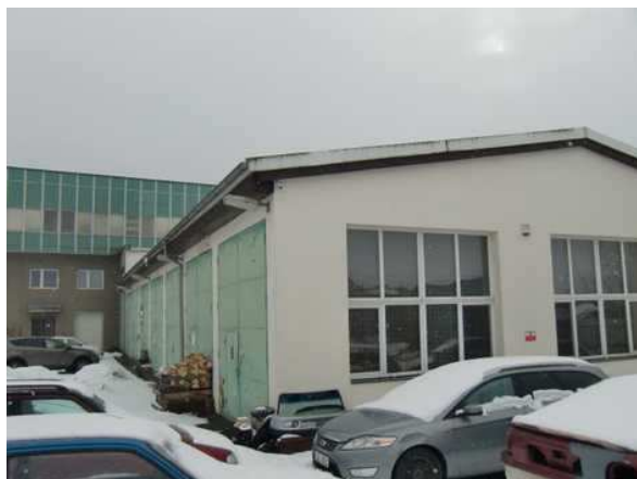
budova garáží (parc.č.1396/1)
