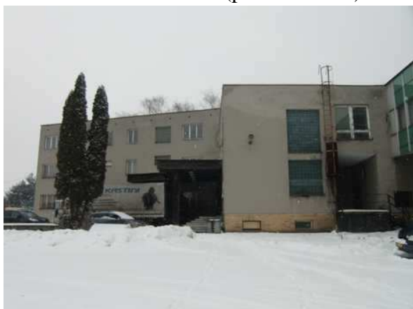
I. a III. admin. budova (parc.č.1394/1, 1395/1)
