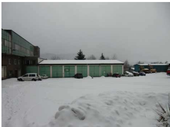
budova garáží (parc.č.1396/1)
