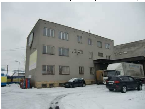
III.admin. budova (parc.č.1395/1)
